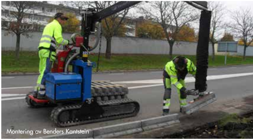
Montering av Benders Kantstein
