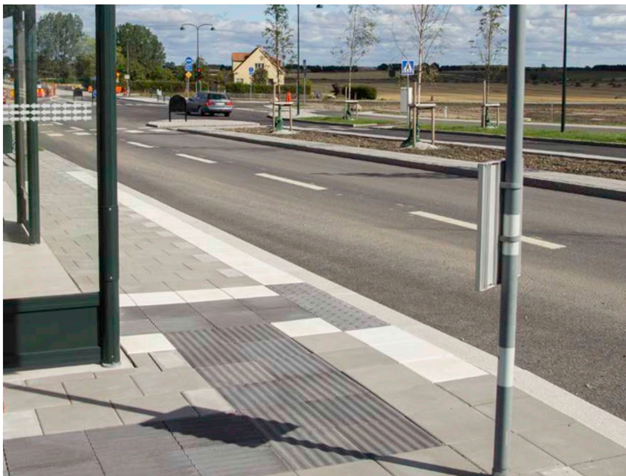
BENDER SIENA PLATTOR FASAD GRÅ, BENDER SINUSPLATTA GRAFIT, BENDER STAR SLÅT HEL-PLATTA SUPERVIT, BENDER KUPOLPLATTA GRAFIT OCH BENDER SPIKMA BUSSHÅLLPLATTSSTÖD
