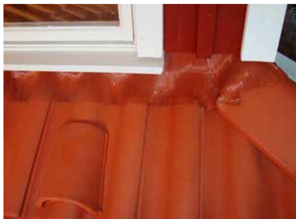
Montering av vägganslutning. På bilden syns även Luftningspannan, se texten.
