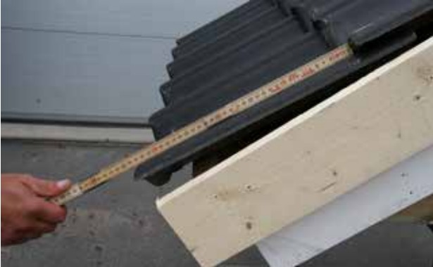
Montagebild 1. Beginnen Sie damit, den untersten Universal-Giebel mit Hilfe von Schneidwerkzeug in die entsprechende Länge zu bringen. Messen Sie dazu den Abstand von der Unterkante der untersten Dachsteinreihe bis zur Unterkante der zweiten Dachsteinreihe. Addieren Sie 10 mm als Abtropfüberstand dazu.
