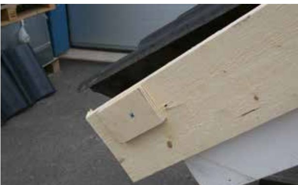
Montagebild 3. Schieben Sie einen Distanzklotz in der Stärke des Ortganglappens des Universal-Giebels an die Stelle des unteren Schraubloches und lösen dabei die mechanische Befestigung des vorher provisorisch angebrachten Anfanggiebels. So garantieren Sie eine korrekte Ausrichtung aller Giebel. Des Weiteren wird der Einbau von Fugendichtstreifen als Insektenschutz unterhalb der Ortganglappen auf die vom Dach abgewandte Ortgangbrettstirnseite empfohlen.
