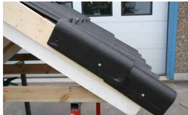
Montagebild 5. Befestigen Sie die weiteren Universal-Giebel durch die vorgegebenen Schraublöcher an die stirnseitige Holzunterkonstruktion, welche eine Mindeststärke von 24 mm aufweisen muß. Legen Sie die Giebel von unten nach oben, immer mit der empfohlenen Fugenbreite an die Unterkante der nächsten Dachsteinreihe, was Sie bis zum First fortsetzen.
