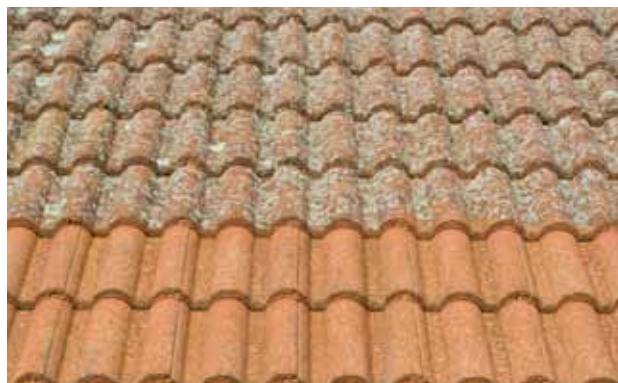
Dachreiniger - Bender Betonreiniger
