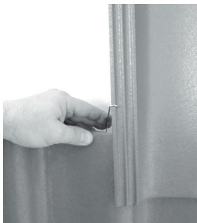
Dachsteine eindecken und die Klammer in den ersten Wasserfalz des überdeckenden Steins drücken.
