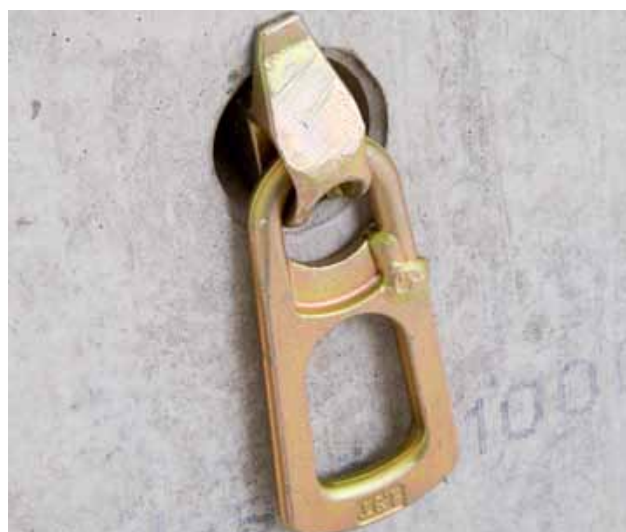
Ankerhode for løft av L-element
