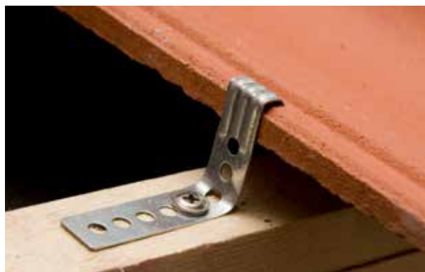
Montering av Takfotklammer
