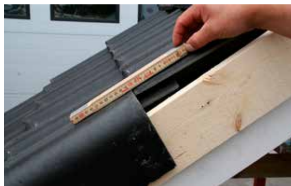
Monteringsbild 4. Lyft gavelbeslaget i överkant så att det får samma nivå som takpannan det möter. Detta medför att man undviker horisontella öppningar vid överlappningarna.
