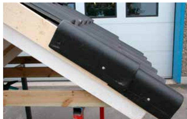
Monteringsbild 5. Borra i anvisningen och skruva fast gavelbeslaget i vindskivebrädan med rostfri skruv. Lägg överkanten på nästa gavelbeslag dikt mot nedre kanten på takpannan i rad nummer tre så blir gavelbeslagens täckande längd samma som takpannornas läktavstånd. Fortsätt så upp tillnocken.
