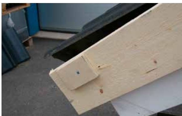
Monteringsbild 3. Lägg en distanskloss motsvarande gavelbeslagets betongtjocklek vid nedre skruvhålet på första gavelbeslaget för att det ska få samma riktning mot vindskivebrädan som de överlappande gavelbeslagen.
