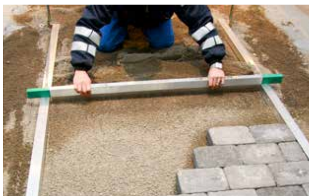
Bilde 1. Baner og avretningsbrett
