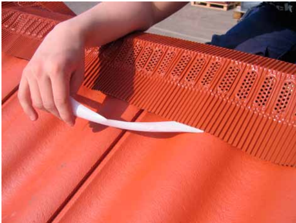
Kuva 2. Poista teippi nauhan alapuolelta.
