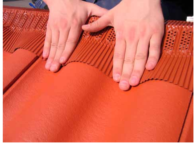
Kuva 4. Muotoile nauha nyt painamalla sitä harjalta kohti tiilen uran pohjaa. Huolehdi, että se tiivistyy hyvin tiileen kiinni.
