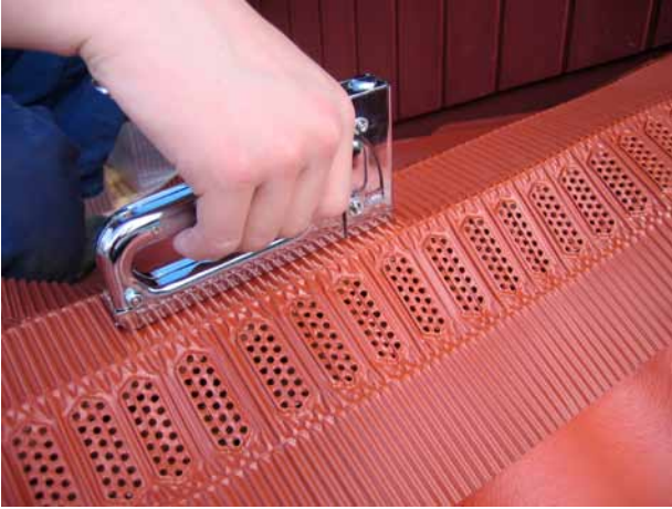
Kuva 1. Keskitä nauha harjalaudan keskelle. Kiinnitä se n. 30 cm välein. Käytä nitojaa tai huopanauloja.
