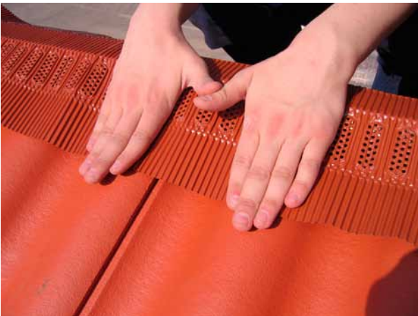
Kuva 3. Taita reunat ja paina ne kiinni tiilen harjalle. Huomioi, että tuuletusaukot eivät peity. Ilman tiilen alta pitää vapaasti päästä tuulettumaan harjatiilen alle.
