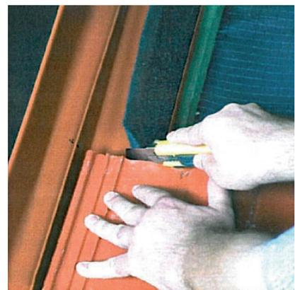
Beim Eindecken der seitlichen Anschlüsse am Dachsteinkopf den Schaumstreifen einschneiden, damit die Zwischenräume geschlossen und damit regensicher bleiben.
