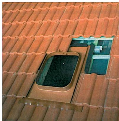
Seitliche Anschlüsse mit dem Material der vorhandenen Dachsteine durchführen. Anschlusssteine zusätzlich gegen Windsog sichern (z.B.: Schrauben durch Schraubloch der Mittelwulst oder Sturmklammer benutzen).
