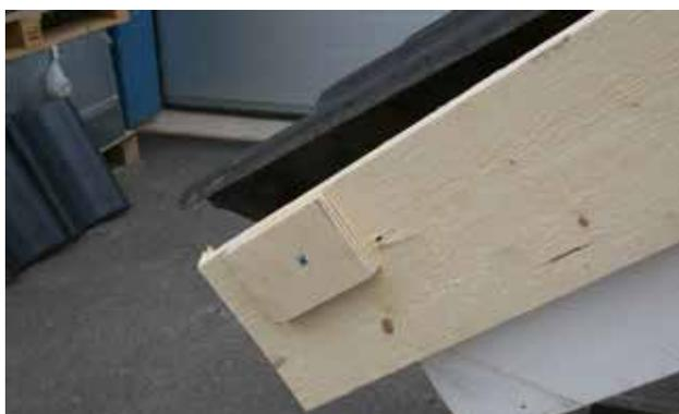
**Montagebild 3.** Schieben Sie einen Distanzklotz in der Stärke des Ortanglappens des Universal-Giebels an die Stelle des unteren Schraubloches und lösen dabei die mechanische Befestigung des vorher provisorisch angebrachten Anfanggiebels. So garantieren Sie eine korrekte Ausrichtung aller Giebel. Des Weiteren wird der Einbau von Fugendichtstreifen als Insektenschutz unterhalb der Ortanglappen auf die vom Dach abgewandte Ortangbrettstirnseite empfohlen.
