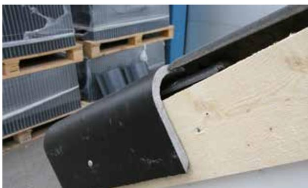
**Montagebild 2.** Schneiden Sie den Universal-Giebel nach Maß wie beschrieben und montieren Sie ihn mit der Schnittstelle nach oben zeigend gegen den Steinfuß der zweiten Dachsteinreihe (als Provisorium). Eine Arbeitsfuge von 2 bis 3 mm zwischen Universalgiebelkopf und dem jeweiligen Dachsteinfuß der darüber liegenden Decksteinreihe wird empfohlen.
