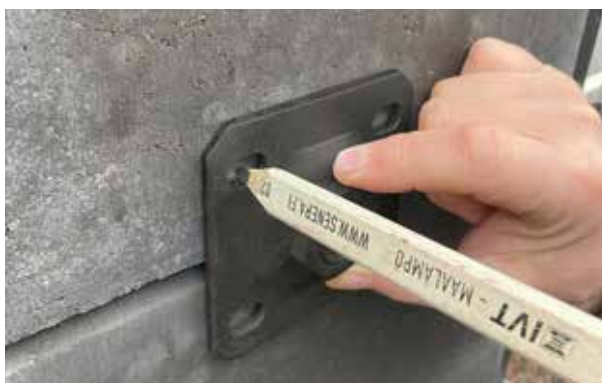
Bild 3. Smidesgrindens gångjärnsplatta.
