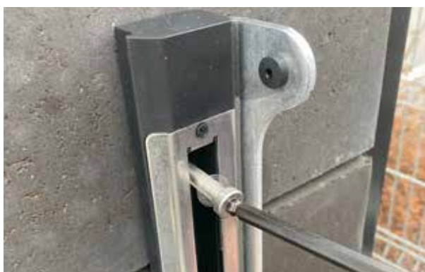
Bild 7. Bult till betongankare.
