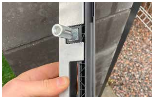
Bild 6. Betongankare i låsplatta.
