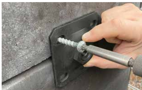
Bild 4. Gångjärnsplattans betongkruv.
