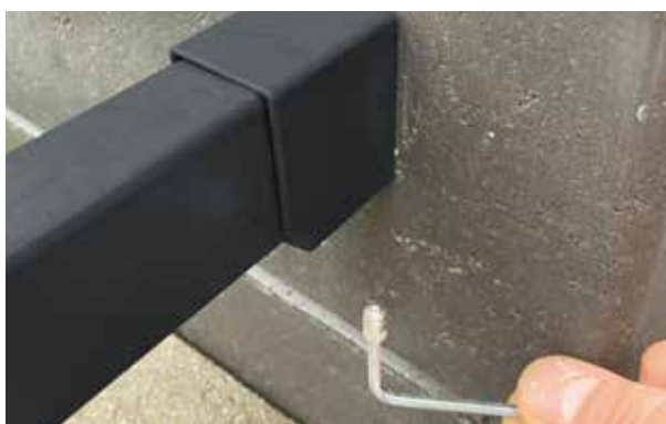
Bild 6. Låsskruvar till vinkelskydd.
