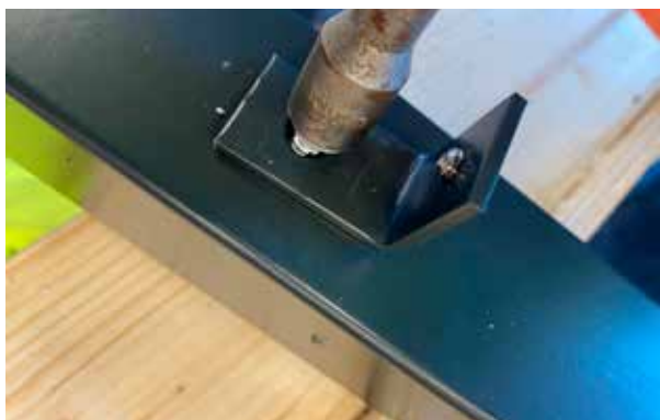
Bild 4. Vinkelfäste i smidesstolpe.
