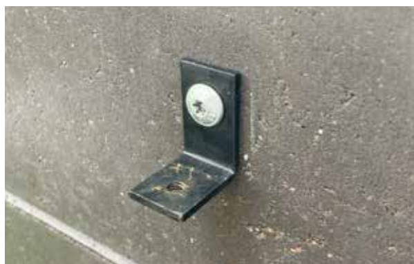
Bild 3. Vinkelfäste i betongstolpe.
