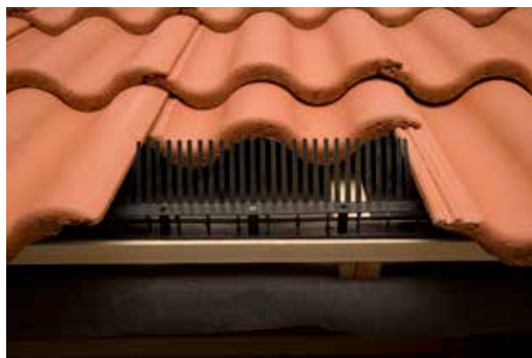
Montering av ventilerat fågelband
