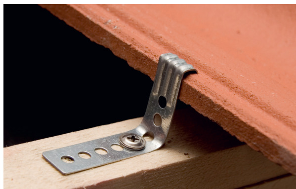
Montering av Takfotsklammer
