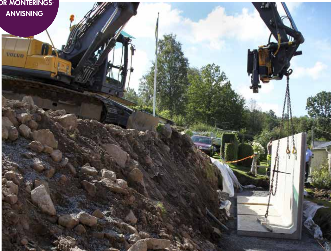
MONTERING AV BENDERS L-ELEMENT
