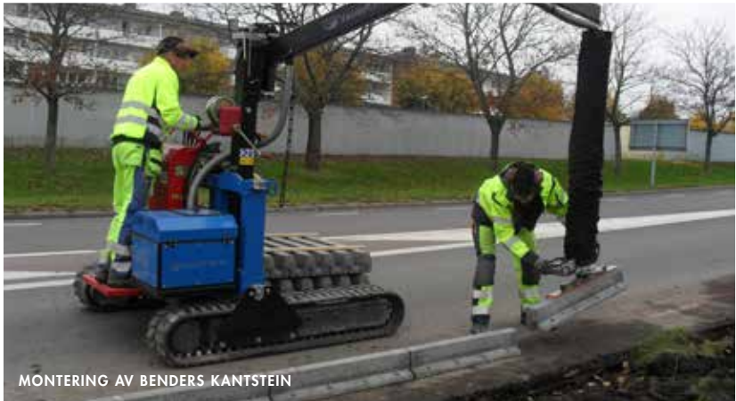
MONTERING AV BENDERS KANTSTEIN
