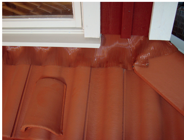
Montering av Vegg- og takavslutningsrull. Bildet viser også Luftingtakstein.
