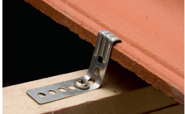
Montering av Takfotklammer
