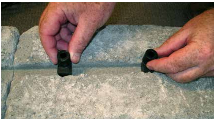
Bild 2. Montering av Boston Låsplugg för lutande mur. Montera två st låsplugg per mursten.
