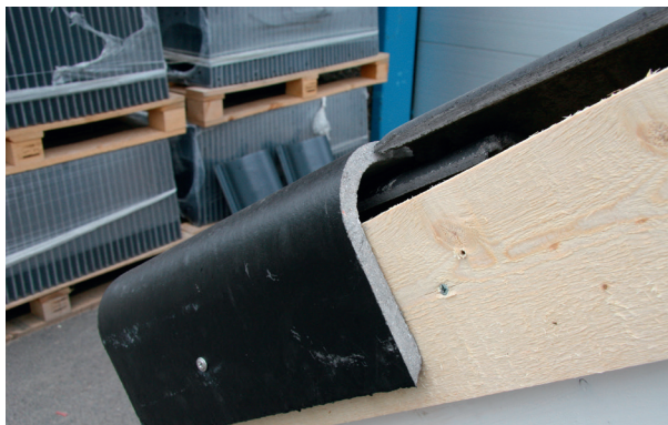
Monteringsbild 2. Kapa sen gavelbeslaget i överkanten efter detta mått. Då döljs kapsnittet av nästa gavelbeslag.
