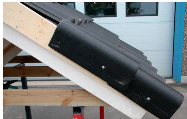
Monteringsbild 5. Borra i anvisningen och skruva fast gavelbeslaget i vindskivebrädan med rostfri skruv med packning. Läggs överkanten på nästa gavelbeslag tätt mot nedre kanten på takpannan i rad nummer tre så blir gavelbeslagens täckande längd samma som takpannornas läktavstånd. Fortsätt så upp tillnocken.
