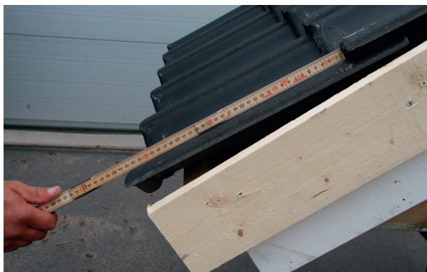
Monteringsbild 1. Börja med att kapa nedersta gavelbeslaget i rätt längd. Mät avståndet från nedre kanten på första takpannan till nedre kanten på takpannan i andra raden och lägg till ca 10 mm.
