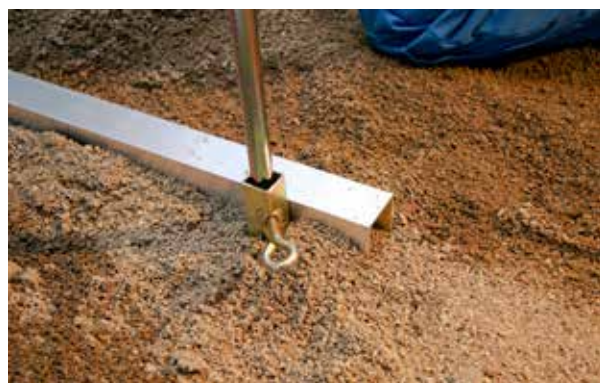
Bilde 2. Jordspyd med justerbart feste gjør det enkelt å montere avretningsskinnene.
