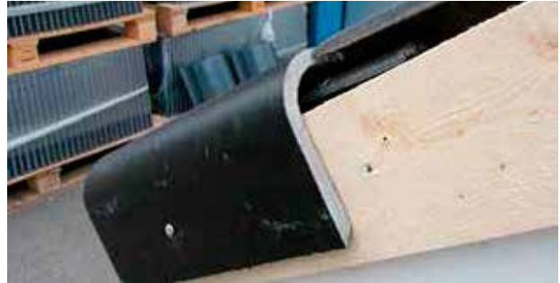
8 pav. Nupjaukite šoninės čerpės viršutinę siauresnę dalį
