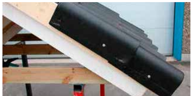
11 pav. Tvirtinant šonines universalias čerpes, pirmiausiai pragrežkite jose tvirtinimui numatytas skyles iki galo.
