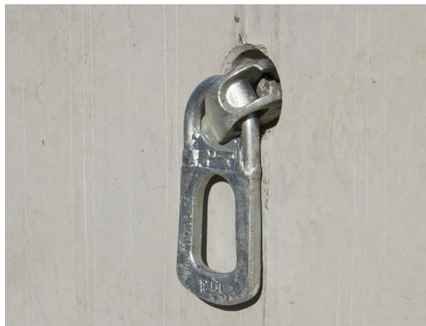
Lengvam ir saugiam atraminių sienelių konstrukcijų pakėlimui įsigykite Benders universalius kėlimo elementus
