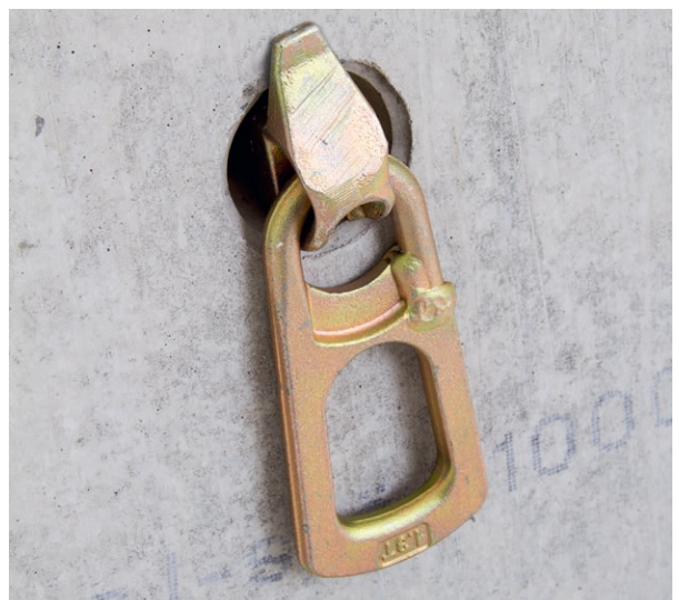
Ankerhode for løft av Lelement
