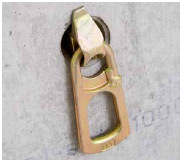
Ankerhode for løft av Lelement
