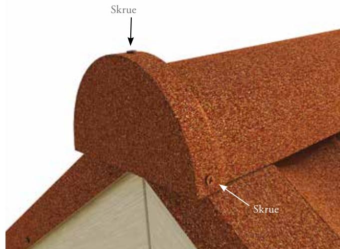
Montering av mønestart
