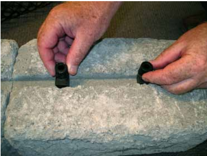
Kuva 3. Lukitusholkin asennus Bendersin 4° kallistuvaan muuriin. Asenna 2 lukitusholkkia / kivi.
