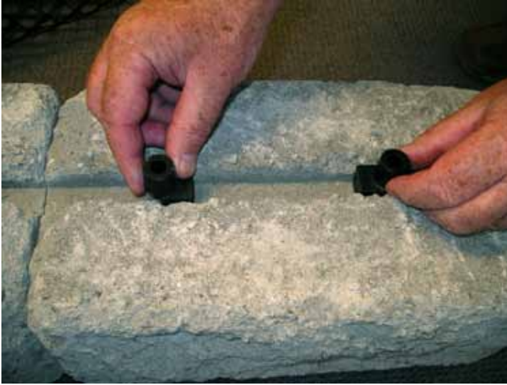
Kuva 2. Lukitusholkin asennus Bendersin pystysuoraan muuriin. Asenna 2 lukitusholkkia / kivi.
