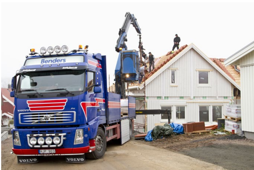
Pilt 1. Kraanaga autolt katusele tõste.
