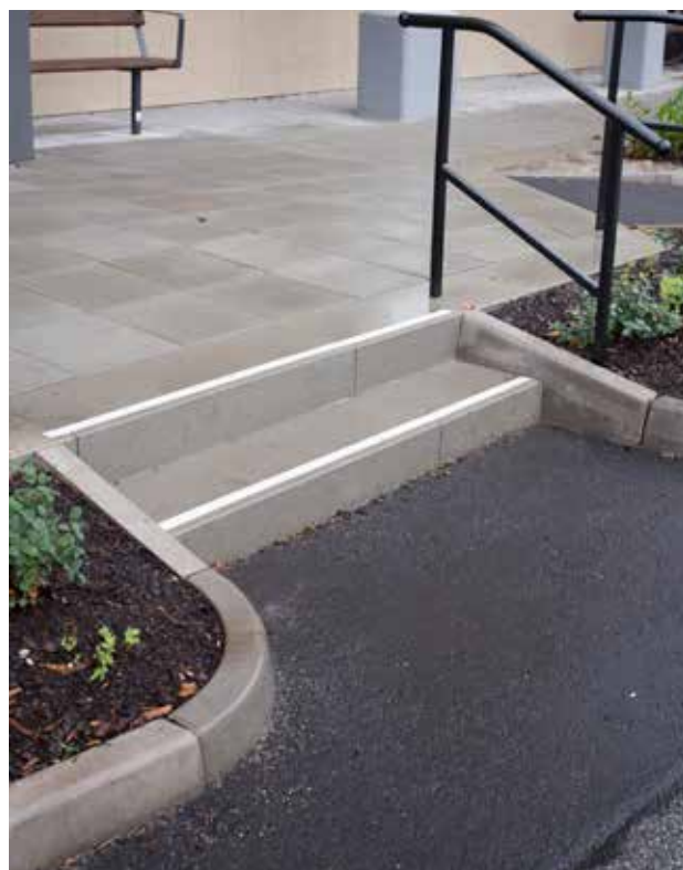
BENDER SPIKMA GATUKANTSTÖD RAK OCH RADIE, BENDER TRAPPBLOCK GRÅ OCH BENDER SLÄTA PLATTOR GRÅ
