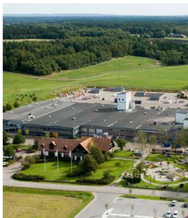
HEAD OFFICE IN EDSVÄRA
