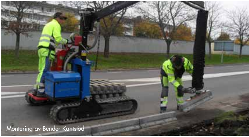
Montering av Bender Kantstöd
