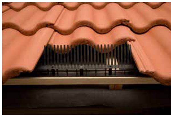
Montering av ventilerat fågelband
