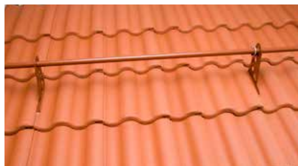
Nock- och takfotsräcke monterat med fäste
