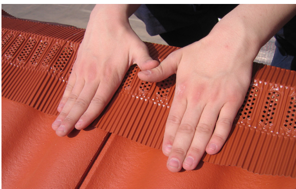
Monteringsbilde 3. Brett ned kanten, form rullen mot taksteinens overside. Vær nøye med at luftningsdelen på rullen ikke havner direkte mot mønekammen. Luften skal vandre fritt fra underkant av takstein til den går ut under mønesteinen.
