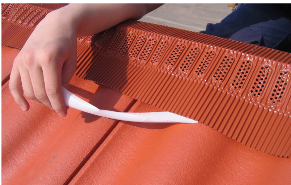
Monteringsbilde 2. Fjern beskyttelsestapen parallelt med leggeretningen.
