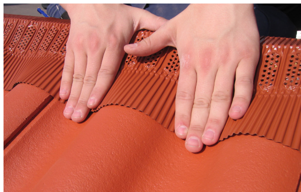
Monteringsbilde 4. Press fra toppen av taksteinen ned mot dalen på steinen. Vær nøye med at kanten ligger tett inntil steinen, for en optimal tetting.
