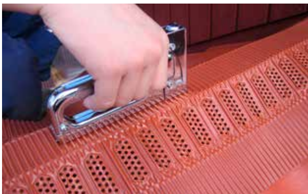
Montering steg 1. Centrera rullen på nockplankan. Fäst rullen med regelbundna avstånd på ca 30 cm. Fäst med häftklammer, pappspik eller dylikt.
