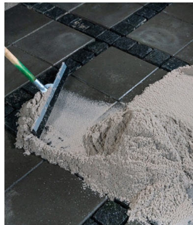
3. Benders Lithomex Quicksand kraabitakse vuukidesse kummist kaabitsaga.
