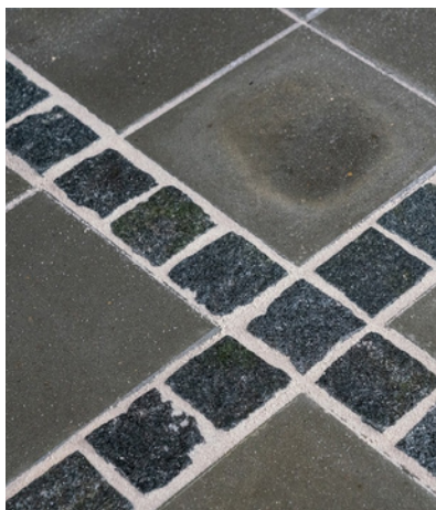
8. Pinnal võib kõndida 24 tunni pärast. Kõvastub täielikult umbes 48 tunni pärast (20 °C juures).
