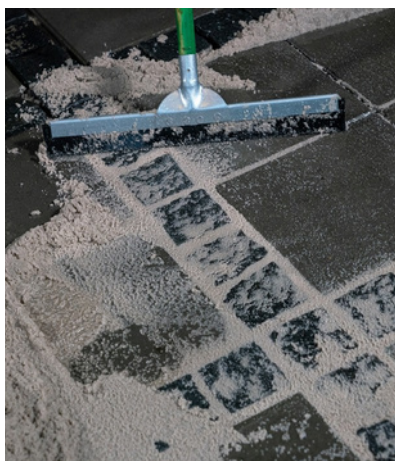
5. Vuugid peavad olema täielikult täidetud ja vähemalt 30 mm sügavused.
