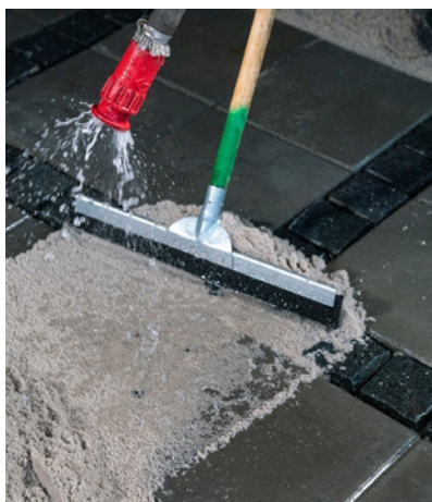
4. Seejärel pritsitakse vuugimassile nõrgal survel vett.
