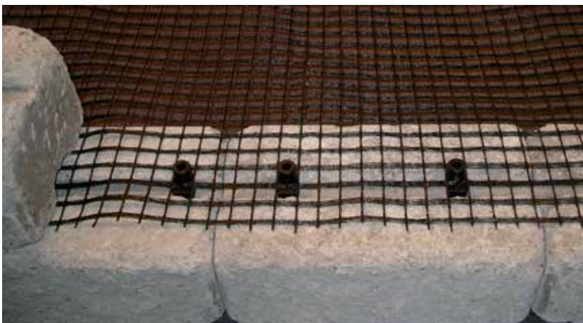
Bild 3. Montering av Bender Geonät på första skiftet. Sätt fast nätet över låspluggarna. Låt pluggarna sticka upp ur tredje raden på nätet så att så mycket nät som möjligt ligger mellan stenlagren utan att sticka ut. Då sitter nätet bäst.
