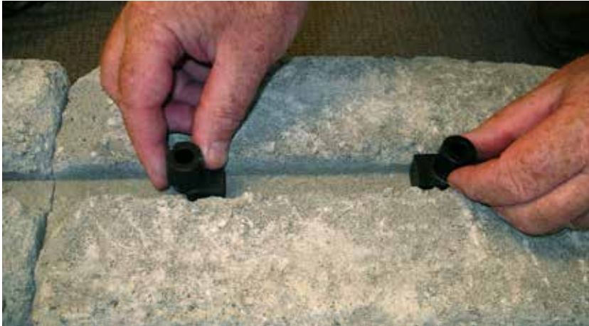
Bild 1. Montering av Bender Låsplugg för vertikal mur. Montera två st Bender Låsplugg per block.
