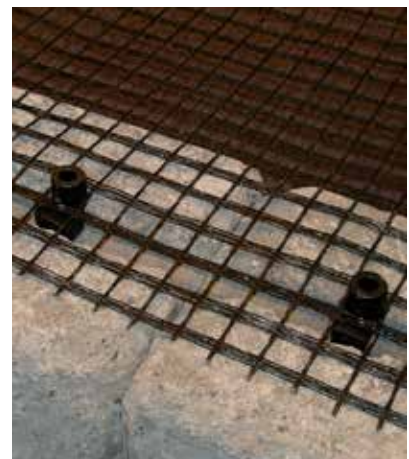
Bild 3. Montering av Bender Geonät på första skiftet. Sätt fast nätet över låspluggarna. Låt pluggarna sticka upp ur tredje raden på nätet så att så mycket nät som möjligt ligger mellan stenlagren utan att sticka ut. Då sitter nätet bäst.
