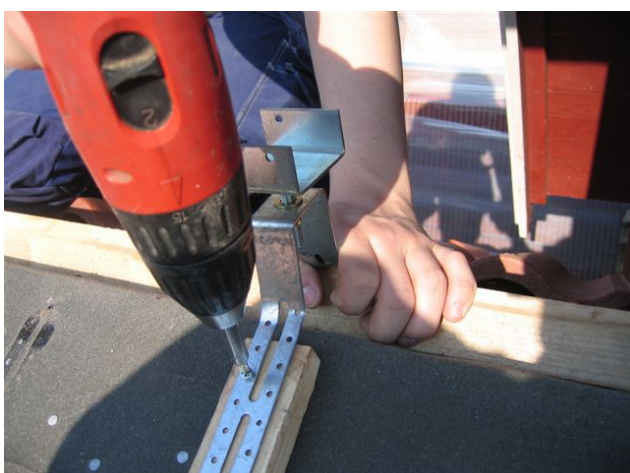
Monteringsbild 3. Skruva fast en nockhållare i vardera ändan av nockbrädan och justera in i rätt höjd.
