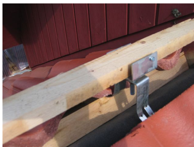
Monteringsbild 6. Lägg dit nockregeln/läkten och fäst den. Lägg sedan dit nocktätningen. Till sist, lägg på nockpannorna. Du har nu fått en optimal, ventilerad och rak nock.
