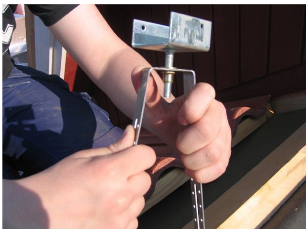
Monteringsbild 1. Böcka U-benen till lämplig vinkel, det gör du lätt för hand. Ställ förskruvningen i mittläge.
