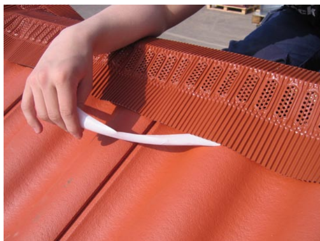
Montering steg 2. Tag bort skyddsteipen parallellt med lägningsriktningen.
